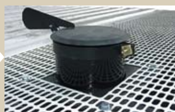
Marmitta residenziale ad alto abbattimento acustico interna al container
