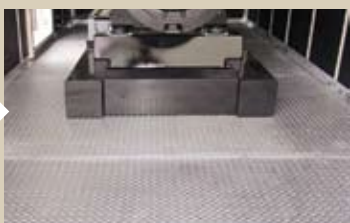
Pavimentazione interna in lamiera zincata mandorlata
