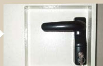
Maniglia per le porte di accesso laterale, con chiusura a chiave
