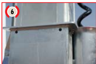
Collari di rinforzo ad ogni fine sezione
